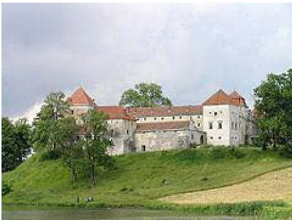
Ryc. 100. Miejsce to szczyciło się pięknym zamkiem
