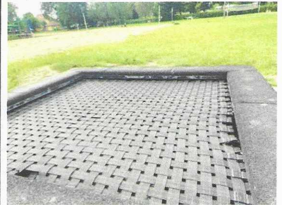
Tylko po prawej stronie widać kilka naderwanych mocowań trampoliny
